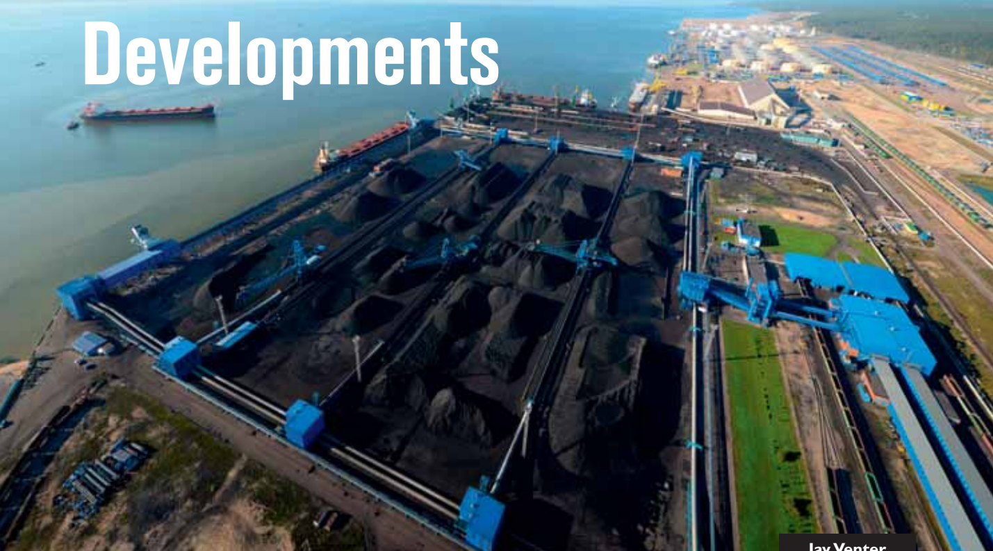
Ust-Luga Coal Terminal (Rosterminalugol).
